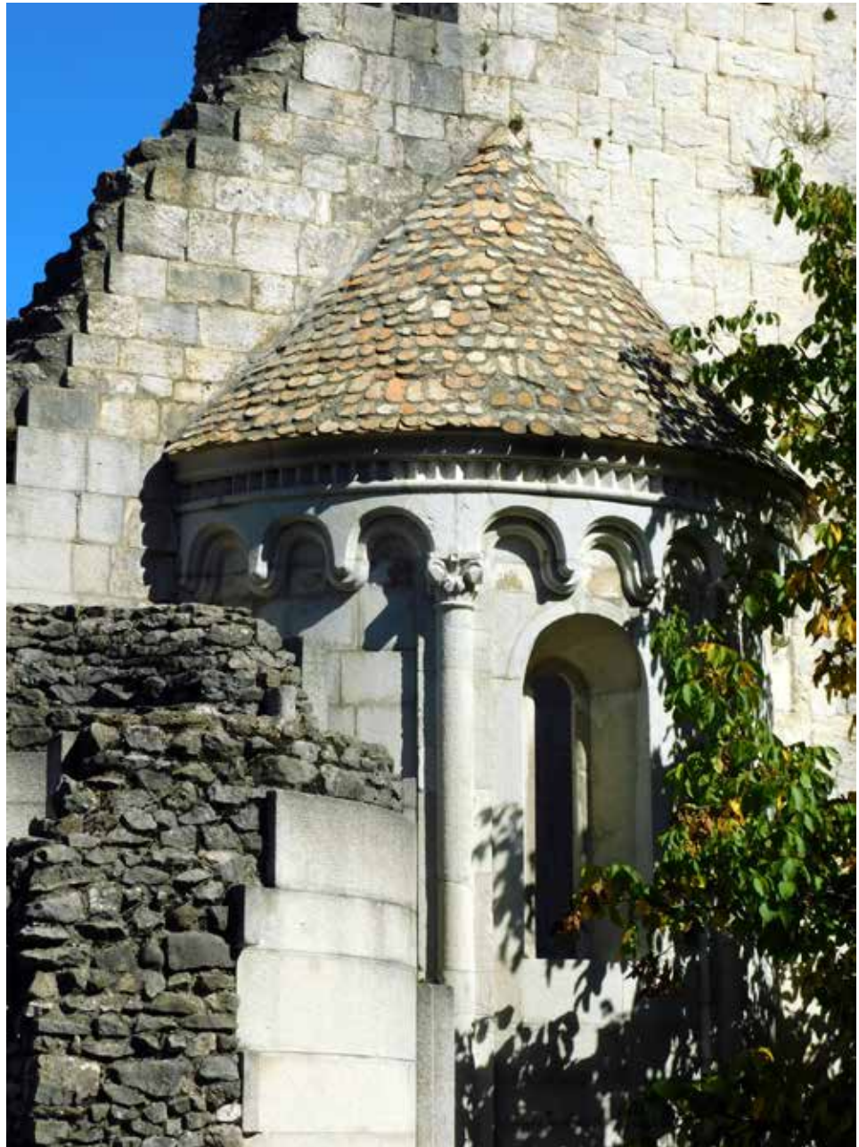
Ami épen maradt / Was intakt blieb
